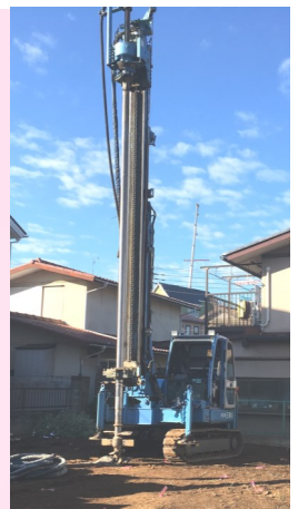
地盤改良工事 ドリルで地盤に穴をあけ、コンクリートを打ち込む。円柱の杭が地中に何本も埋め込まれ地盤が強化される。
