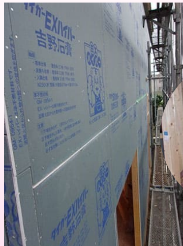
外壁下地ボード設置工事
