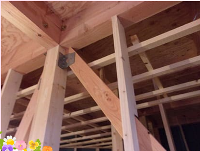
木工事（筋交いと柱の相）
