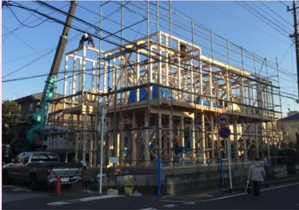
市川市で建築中のH様邸が上棟しました。地鎮祭が終了した後、遣り方、基礎工事、上棟と工事を進め、現在は屋根工事、内部木工事を行っています。一言で説明するならば、遣り方で実際の寸法、配置等の目印を付け、基礎工事で家の土台造り、上棟で家の骨組み造りを行います。H様邸は、機能性だけでなく、デザイン性にもこだわっていて、完成までの工程がとても楽しみです。
